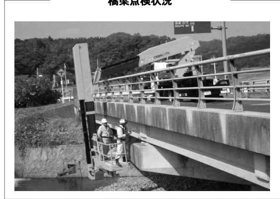
橋梁点検状況
