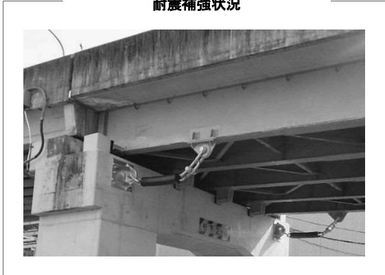
耐震補強状況
