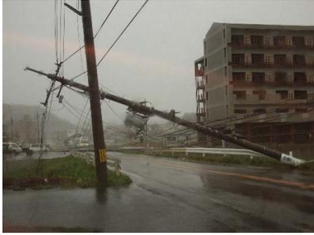
写真－１ 台風による電柱倒壊状況
