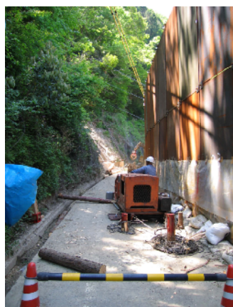
狭隘な場所での作業
