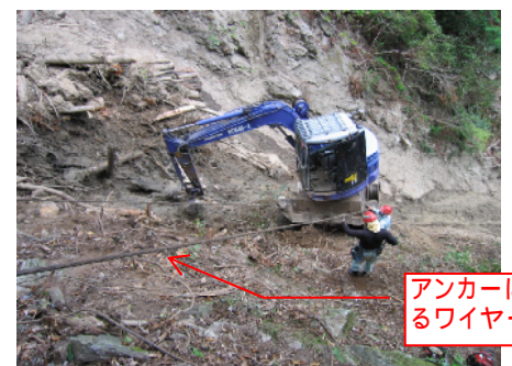
高所作業用機械による崩積土の除去
