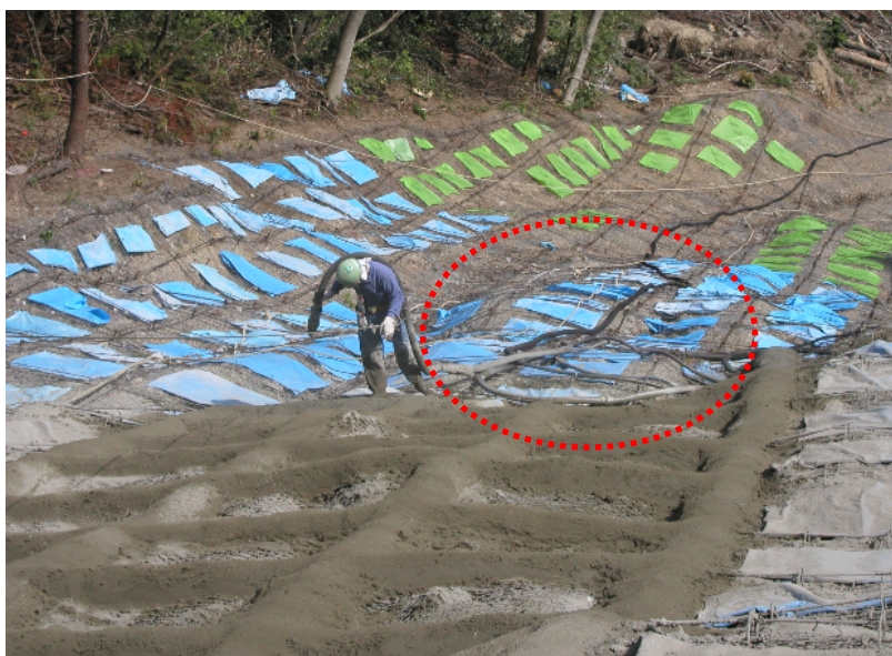
セパレートショット工法によるモルタル吹付
