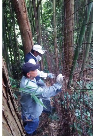
ワイヤーメッシュ 点検作業
