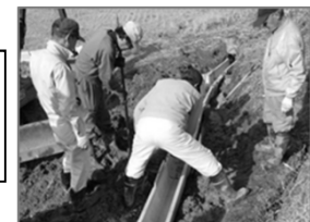
老朽化した水路の更新
