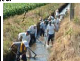
水路の泥上げ
