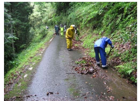
水路の泥上げ作業
