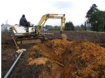
畑地かんがい施設の補修
