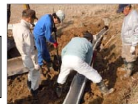
老朽化した水路の更新
