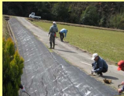
防草シートの敷設
