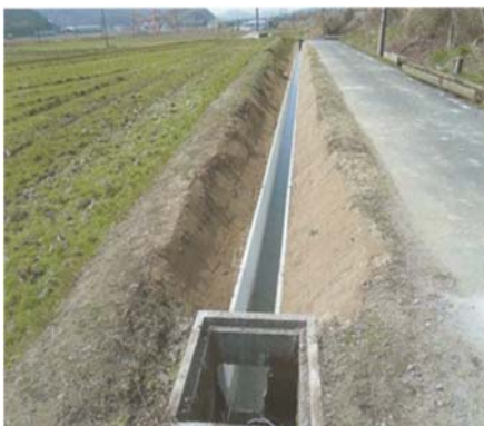
大内地域資源保全会 （備前市） 老朽化した水路の更新
