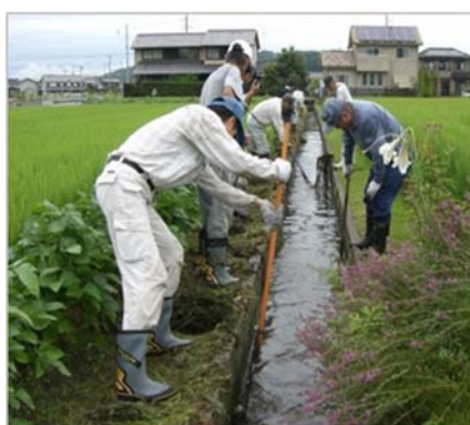
下粒浦地域資源保全会 （倉敷市） 水路の泥上げ
