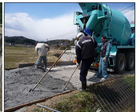
紫竹会活動組織 （津山市） 農道のコンクリート舗装
