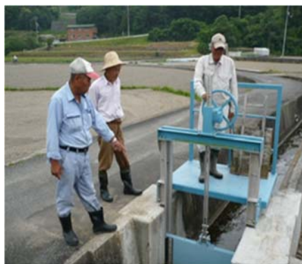
北河環境保全協議会 （笠岡市） 老朽化したゲートの更新
