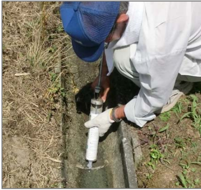
可真下2支部資源保全活動組織 （赤磐市） 水路の補修
