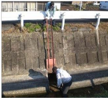
浅海南環境保全協議会 （矢掛町） ゲートの機能診断・補修
