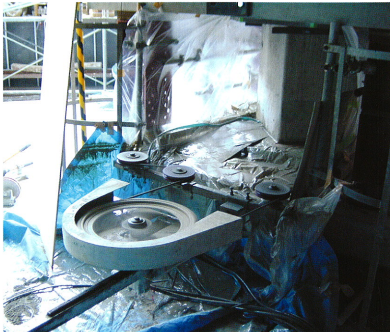
免震装置を挿入する部分の柱をワイヤーソーで切断する。
