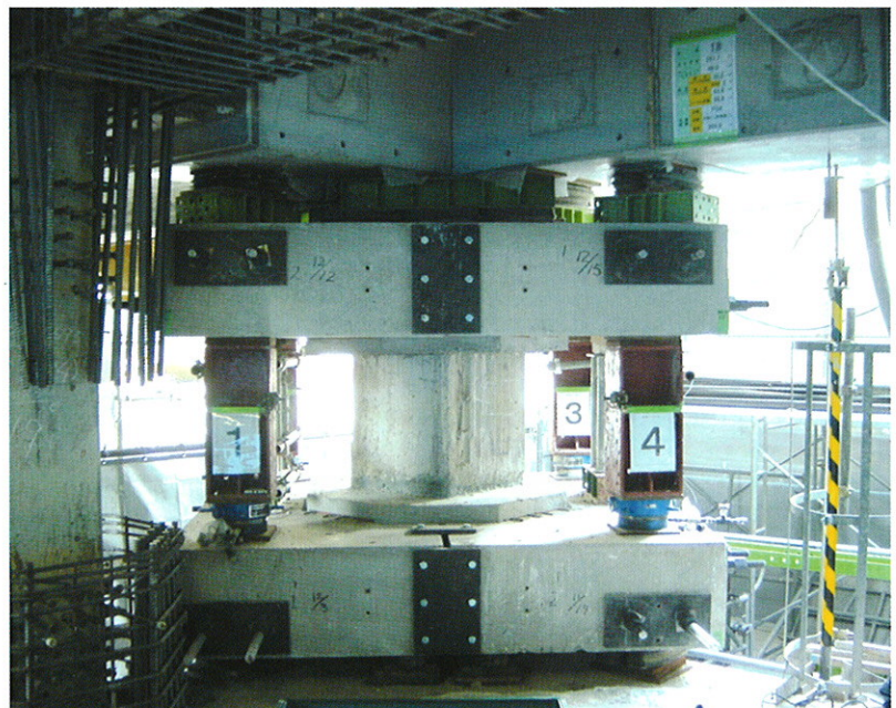
既存柱の上下をPCaブロックで囲うようにしてはさみ込み、上下間に油圧ジャッキを設置し、荷重の仮受を行う。ジャッキには変位計を設置し、荷重状態を管理する。
