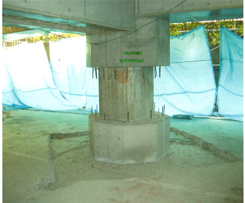
既存柱の補強のため、補強コンクリートの増し打ちを行う。
