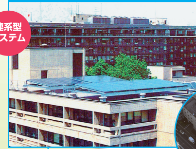
岡山県庁 所在地：岡山市北区内山下二丁目4番6号 ●出力：20kW
