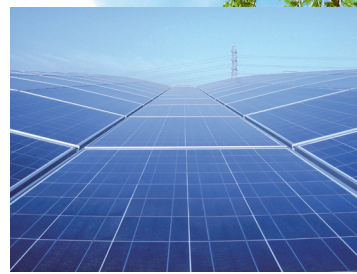
鶴新田浄水場
