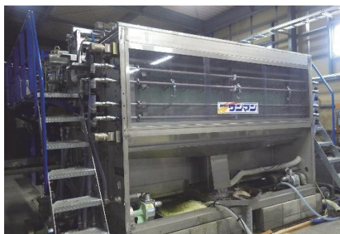
共同利用施設（ノリ大型全自動乾燥機）
