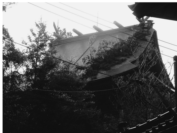
平成16年台風23号による被害 (真庭市・木山神社本殿)
