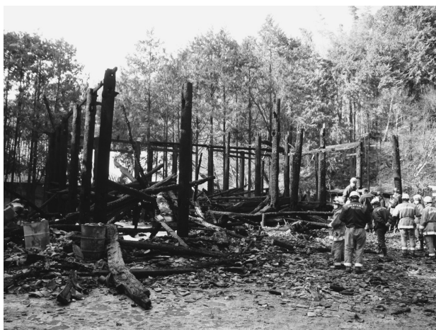
岡山市・金山寺本堂焼失現場 (平成24年12月24日出火)
