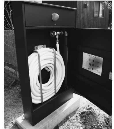
屋外消火栓の例
