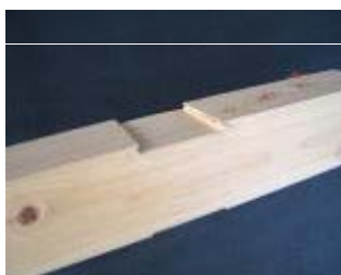
めり込み状況
