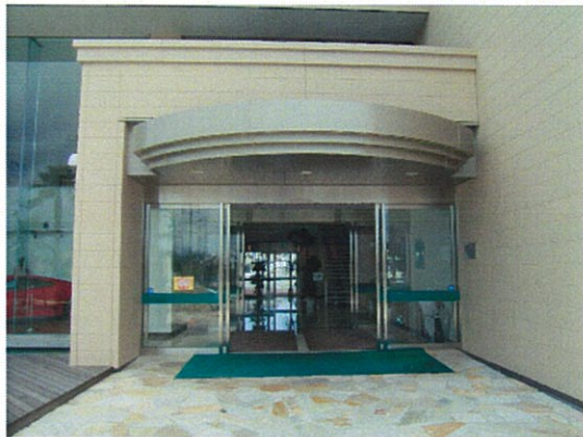
エントランス廻り
