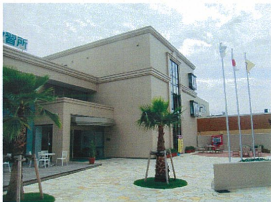
エントランス廻り
