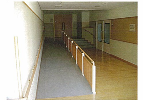
大ホールのステージに車椅子の方も上げられるように スロープを設けている。ステージ脇には大ホールから 直接ステージに上げられるスロープも用意する。
