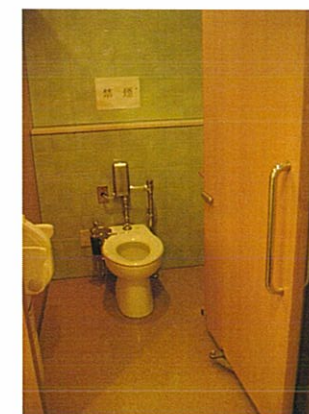
男子トイレ、女子トイレにオストメイト対応の洋 風便器を設けている。フースの扉巾を80cmと 広く取っている。
