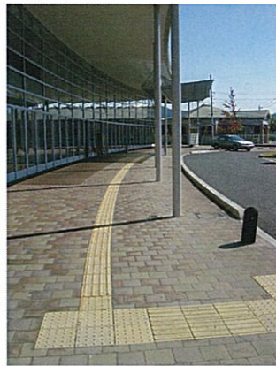
受付カウンターから歩道まで導かれた視覚障害者点字ブロック
