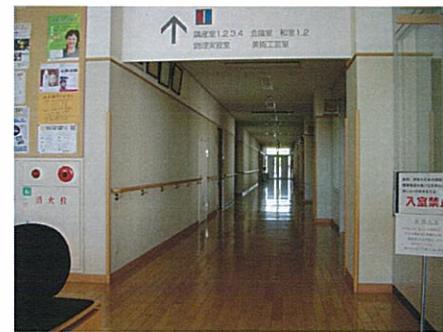
廊下は車椅子が十分すれ違えることができるよう 広く取り、手すりも設置している。
