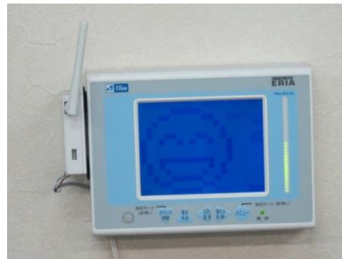
電力監視システム
