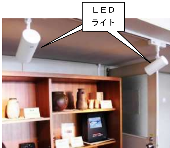
発電した電力の利用状況
