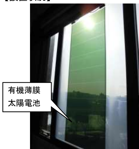
設置されたOPVモジュール
