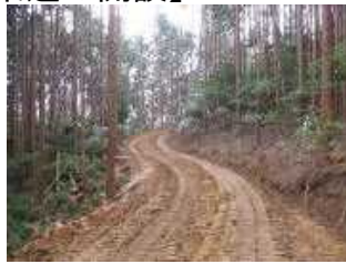
(出来上がった作業道)
