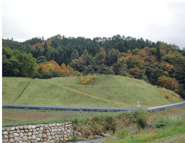
中津河大切坑捨石堆積場
