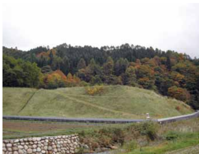
中津河大切坑捨石堆積場
