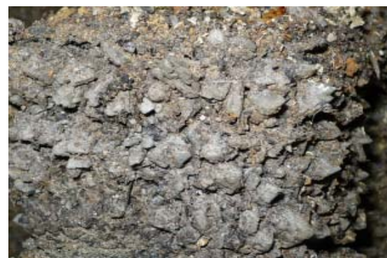
写真 発酵槽内部の結晶化物
