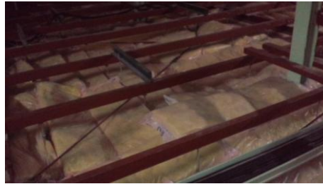
断熱対策の状況（天井）
