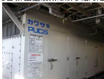
コージェネレーションシステム
