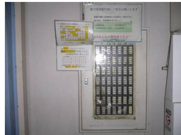
電源切断順序の明示
