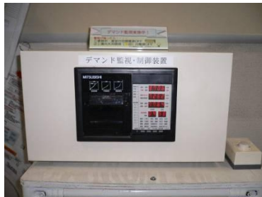
デマンド監視装置設置
