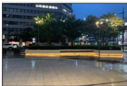
東外構アプローチ 消灯前
