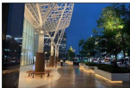
東外構ポール 消灯前
