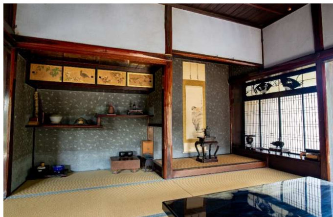
戸田家住宅主屋内部状況
