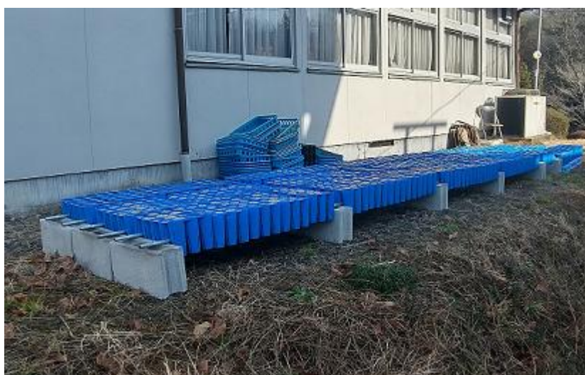
図－6 コンクリートブロックと金属パイプで作成した架台
