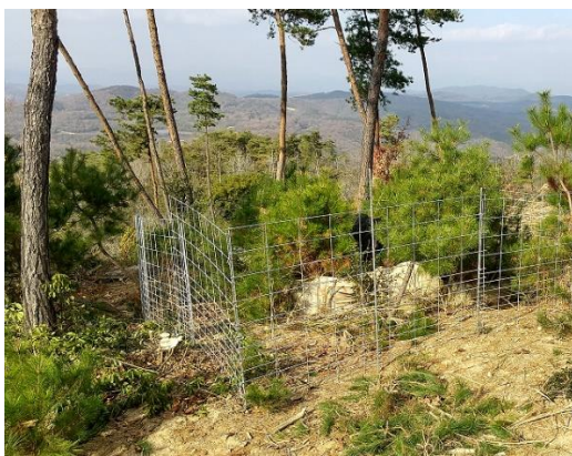
図-16 防護柵の設置1
