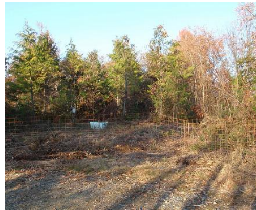
図-17 防護柵の設置2
