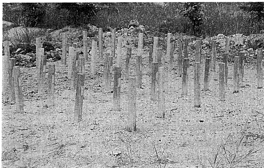
写真1 試験杭の設置状況
