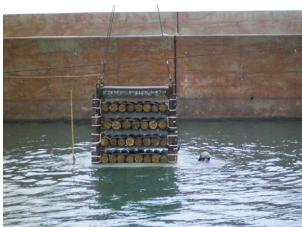
魚礁設置状況
