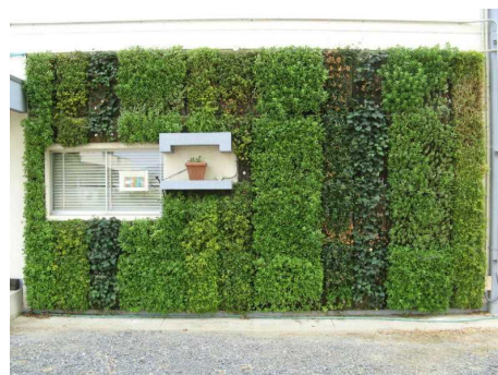
緑化ボードを用いた壁面緑化
