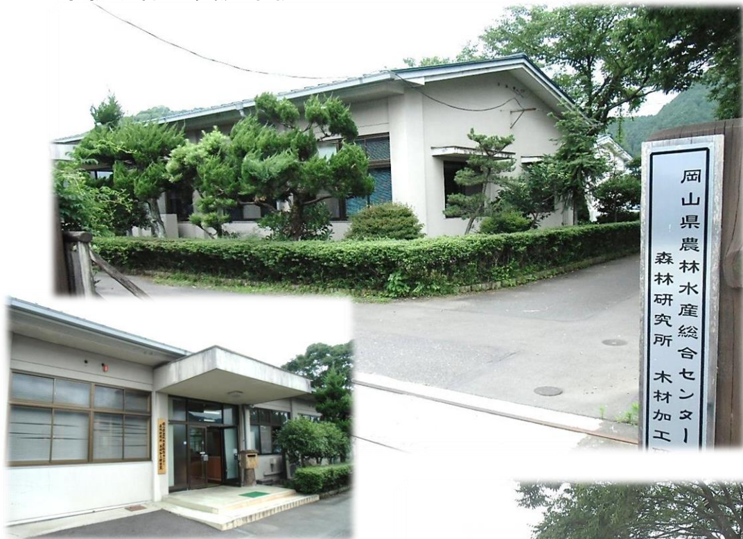
事務所棟（真庭市勝山）
