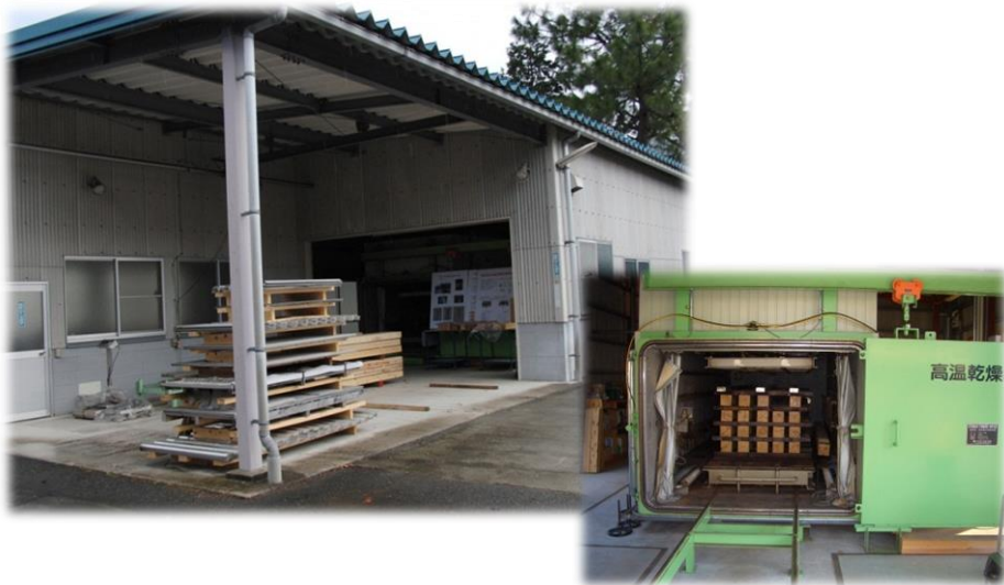
高温乾燥試験棟
