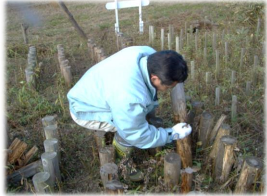
屋外木杭の腐朽調査
