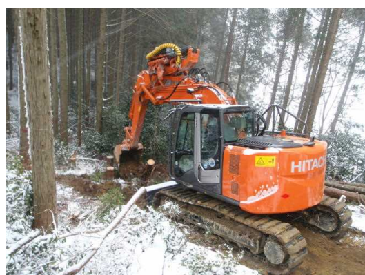
掘削作業（バケット利用）
