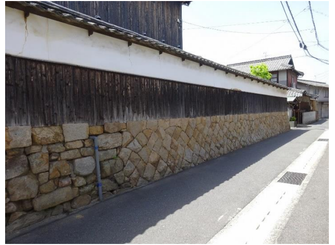
外塀及び石垣
