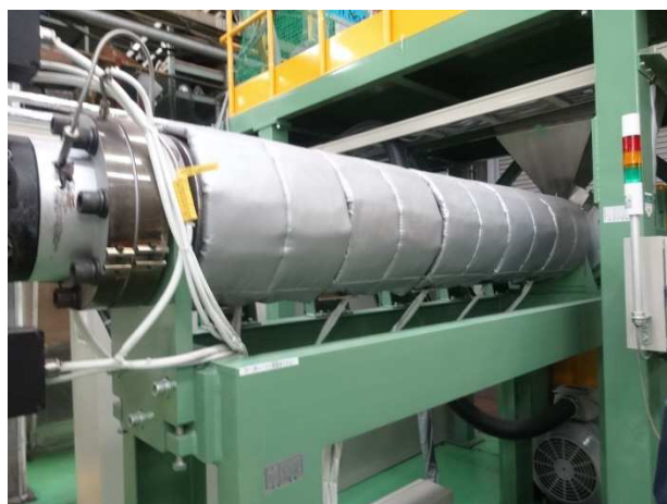
押し出し機のヒータ部の保温
