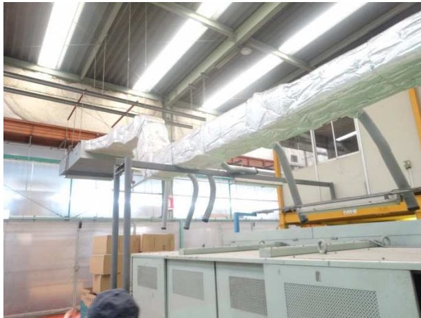
ビニールシートを用いた間仕切り（写真左奥）
