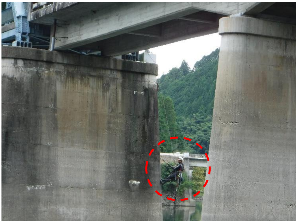
ロープアクセスによる橋梁点検状況
