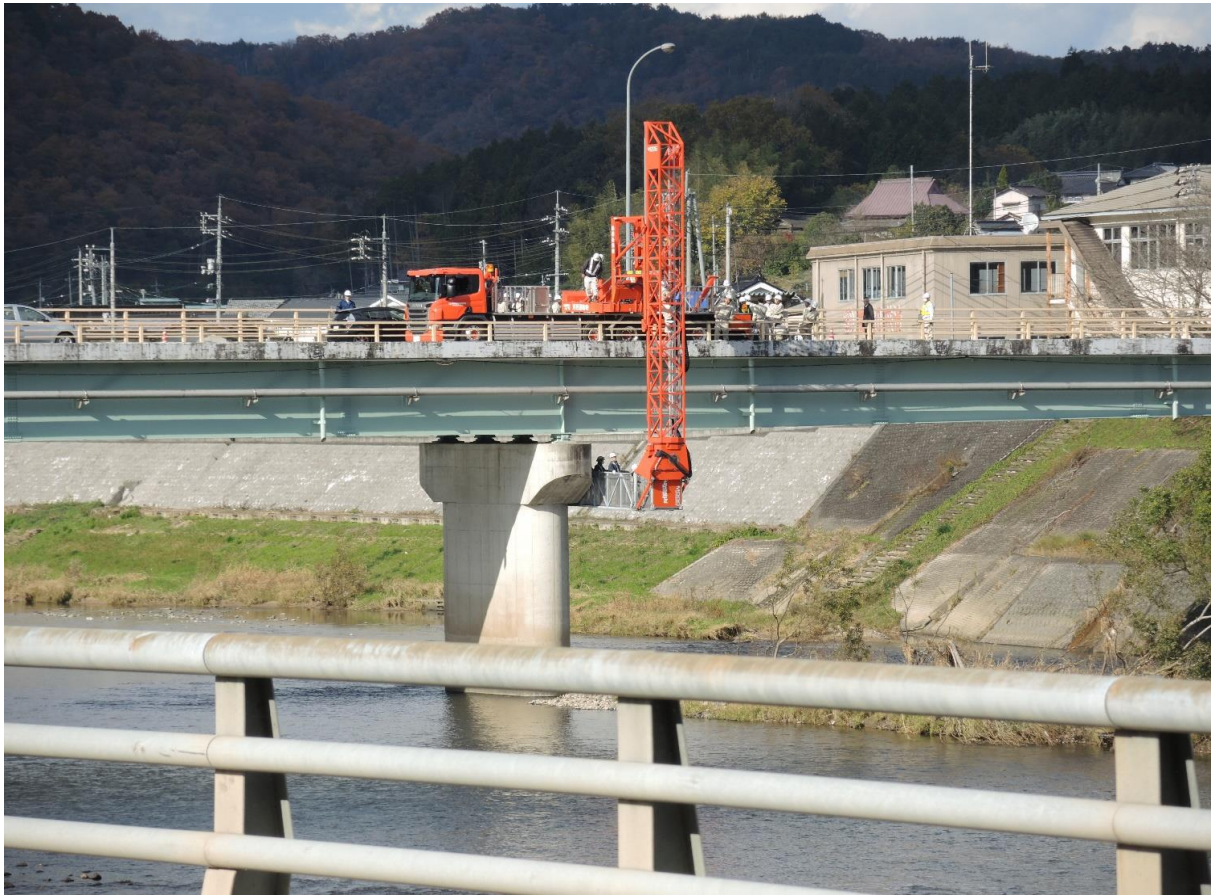
大型橋梁点検車による橋梁点検状況
