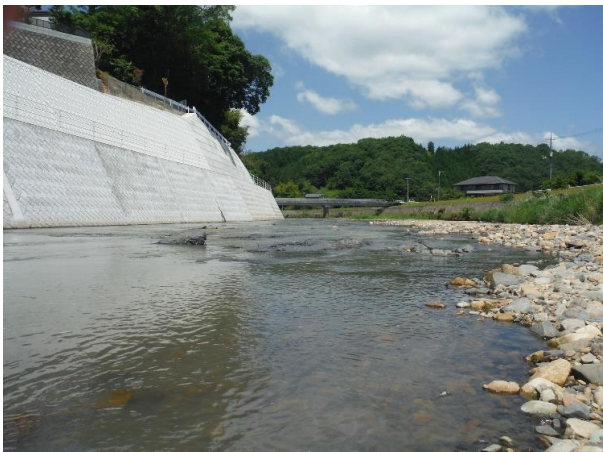
護岸整備の状況
