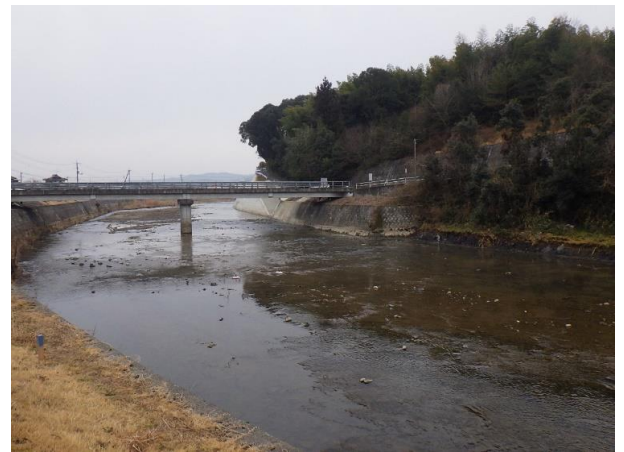
河道掘削の状況
