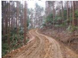
(出来上がった作業道)
