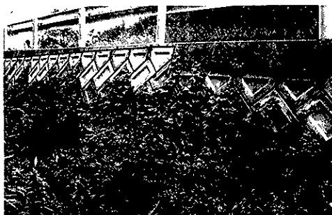
写真15 2年4カ月後の状況。クズが衰退し、良好な 生育を始めた。ブロックの目地を使って登はん している。 1992年9月
