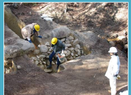
土手状遺構前面石垣（南東から）
