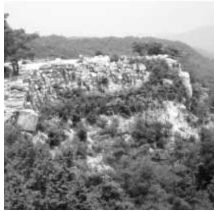
屏風折れの石垣：城壁を外に突出させ、高い石垣を築いています。見張り台などの施設でしょう。
