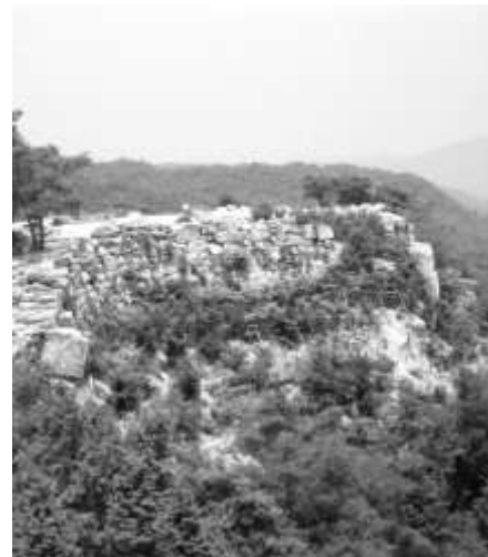
「屏風折れの石垣」：城壁を外に突出させ、高い石垣を築いています。見張り台などの施設でしょう。
