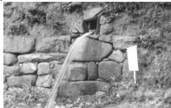
水門：雨水で城壁が壊れないように、城外へ排水する施設。
