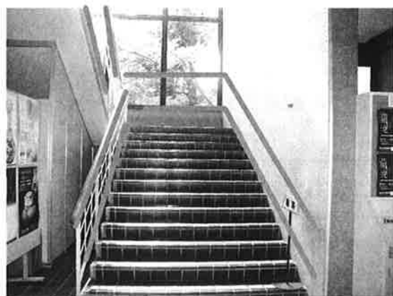
階段手すり（1階から2階へ）
