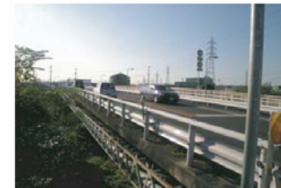
整備後の状況(相生橋付近)
