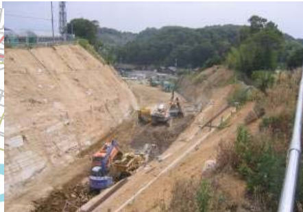
▲工事中の(主)岡山児島線(岡山市箕島)
